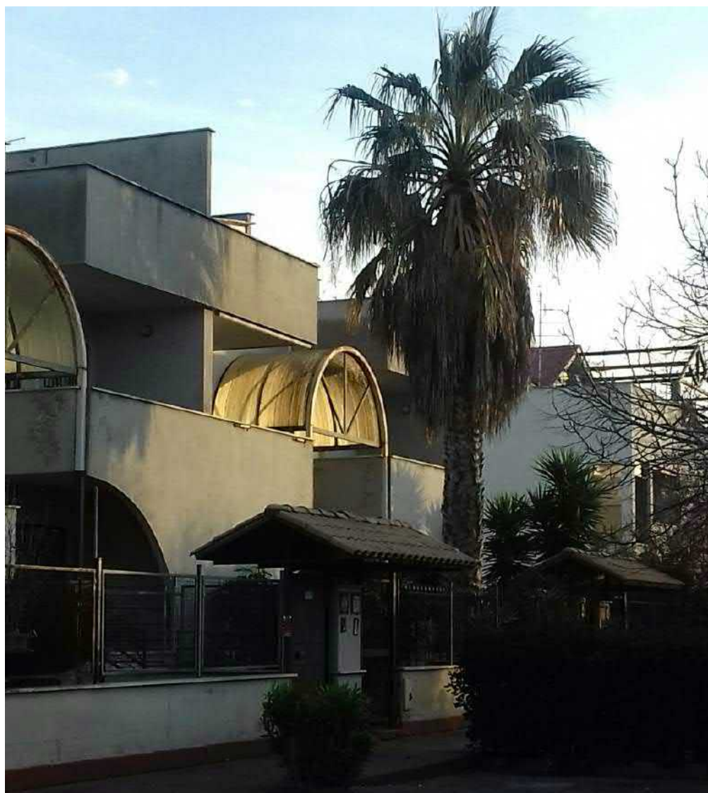
Foto n° 1 – Il fabbricato visto da Via Carlo Fontana
