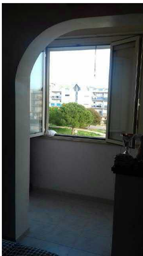
Foto n° 21 – Balcone al piano primo, chiuso per ampliare la camera
