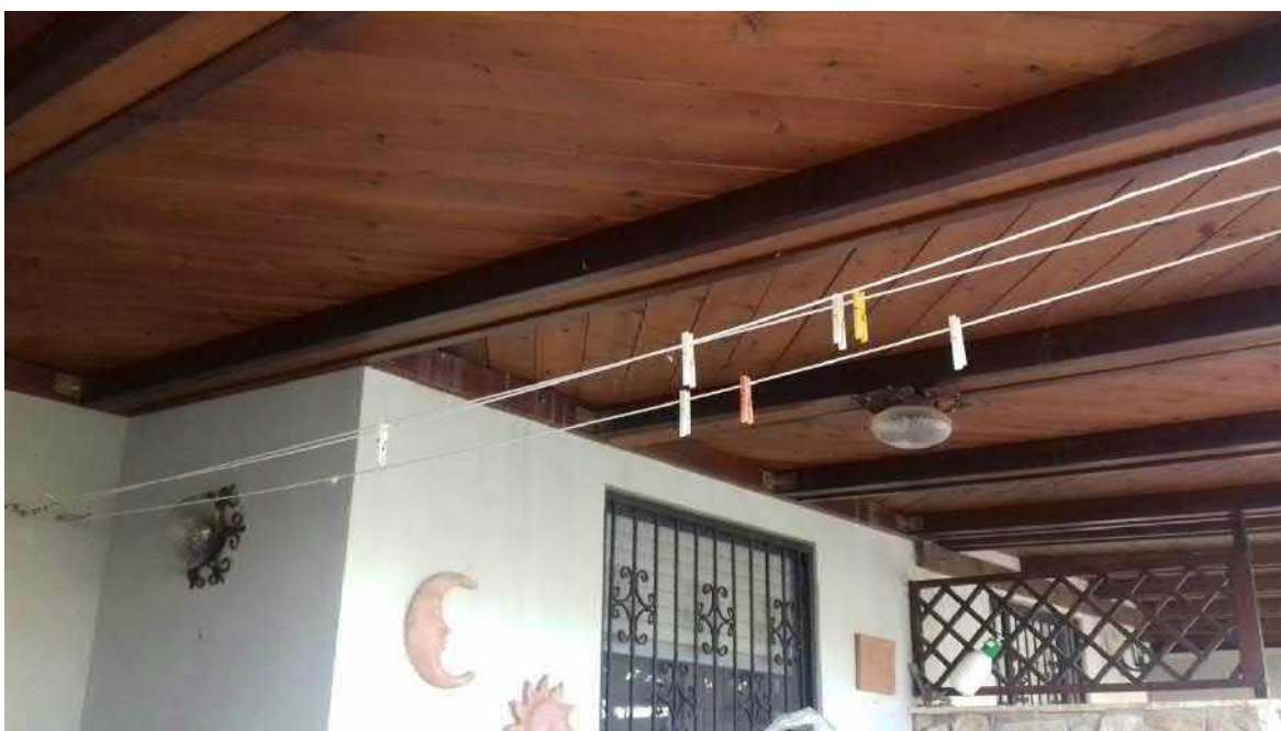
Foto n° 8 – Tettoia di copertura del balcone accessibile dalla cucina
